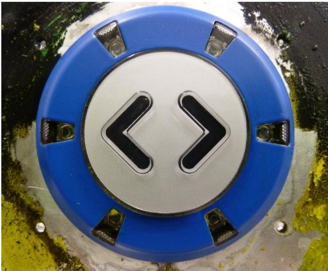
Nach der Graffiti Entfernung kann es zu einer geringen Erweichung und Glanzabfall kommen. Dies ist jedoch, je nach verwendetem Graffiti-Entferner, reversibel nach einer Konditionierung von 24 Stunden. Während der Konditionierung darf die Pulverbeschichtung nicht belastet werden.
